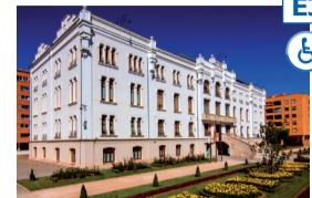
E3 Fábrica de Harinas Flour Factory Usine de Farines
