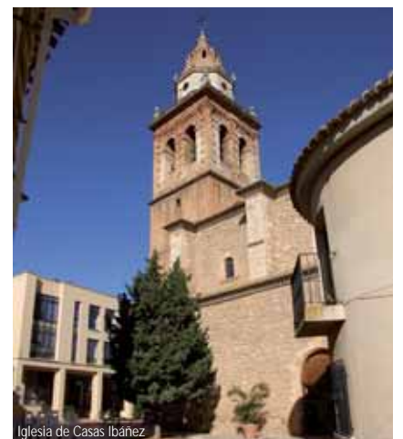
Iglesia de Casas Ibáñez
