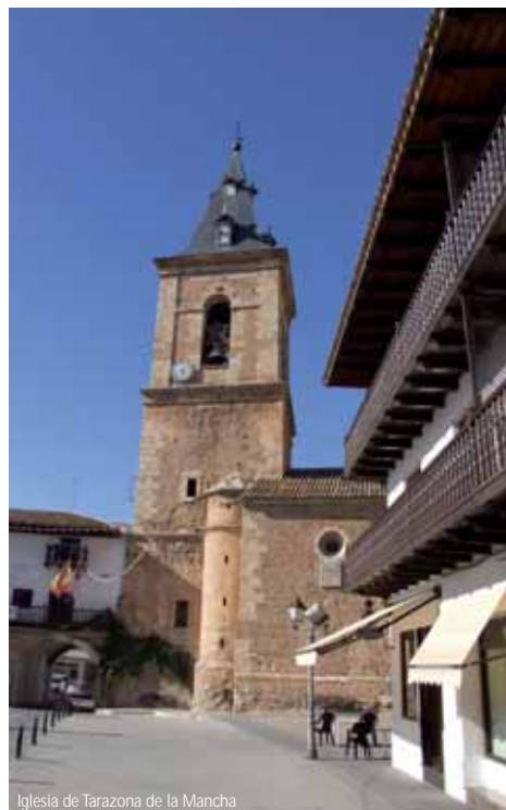
Iglesia de Tarazona de la Mancha
