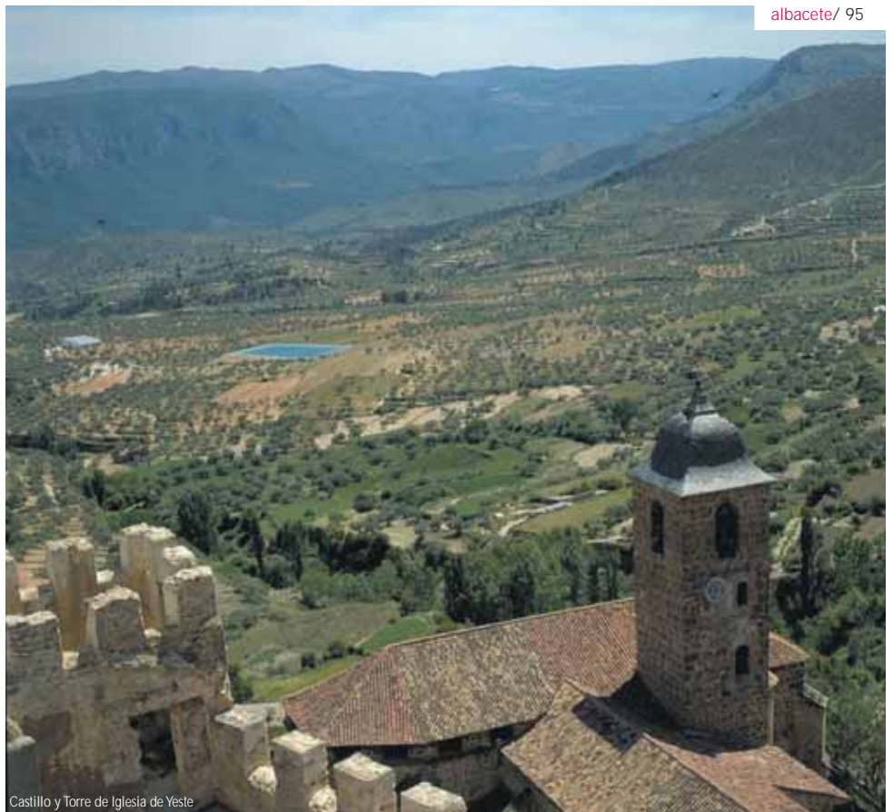
Castillo y Torre de Iglesia de Yeste
